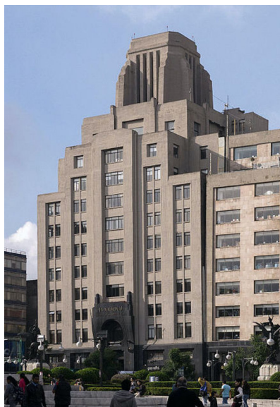
Figura 9. Edificio La Nacional, M. Ortiz Monasterio, Ciudad de México (1932)
