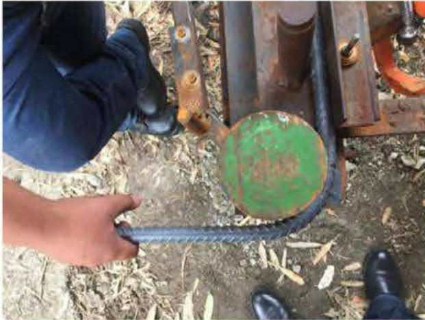
Figura A1. Doblado del refuerzo
