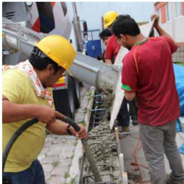
Figura A7. Colado y vibrado de especímenes.
