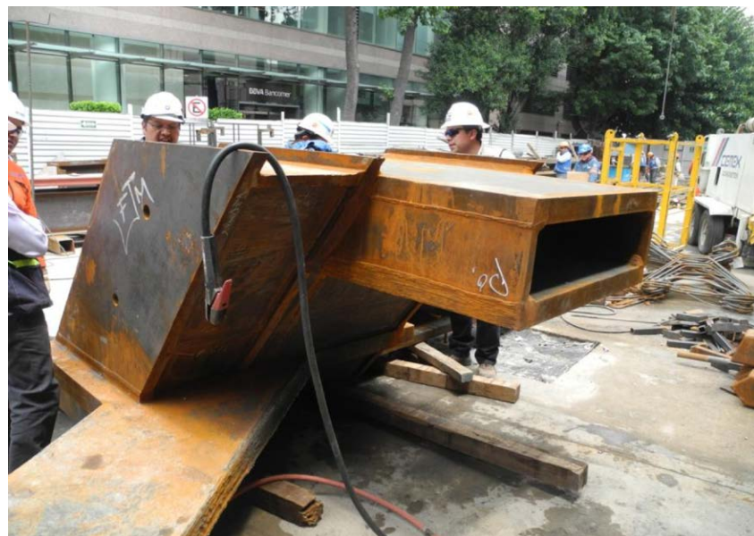
Figura 13. Embebido metálico en muro de concreto para conexión de diagonales.
