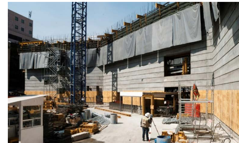
Figura 11. Bandas de 70 cm en el colado de los muros.
