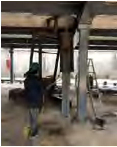
Hincado de vigueta interior.
