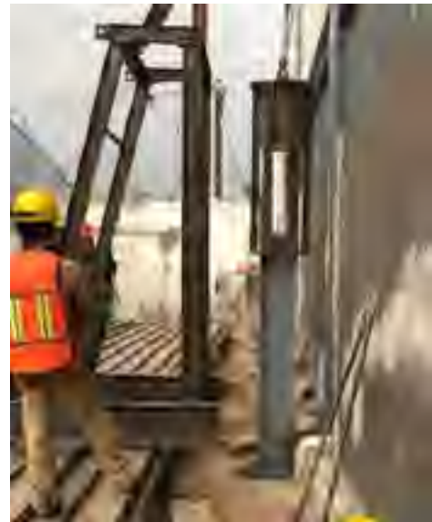
Hincado de vigueta exterior.
