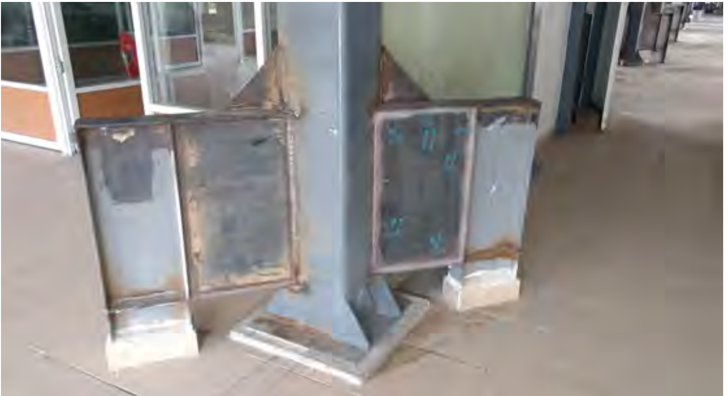
Figura 18. Conexión entre pilotes y columnas de la estructura y la unión entre secciones del pilote.
