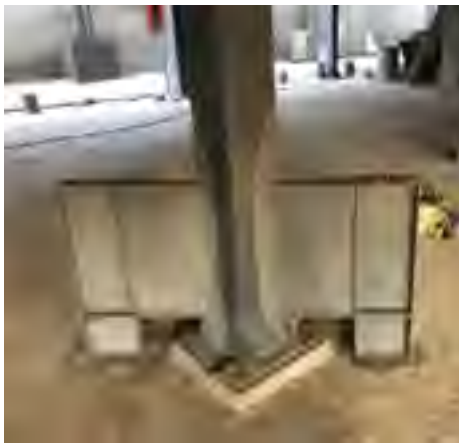
Conexión entre pilotes y columna central.
