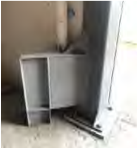
Conexión entre pilote y columna exterior.
